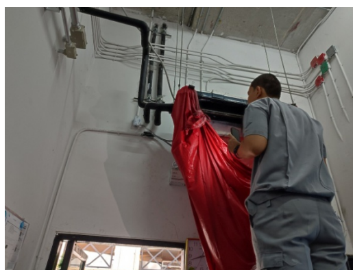
ภาพที่ 4-30 การทำความสะอาดระบบปรับอากาศของโครงการ
