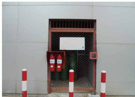
ภาพที่ 4-27 ถังดับเพลิงเคมีติดตั้งไว้บริเวณที่เก็บถังแก๊ส
