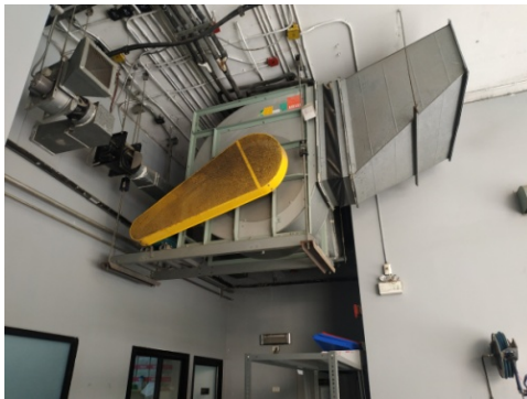
ภาพที่ 4-26 ลิฟต์ดับเพลิง ไฟฟ้าสองดวงฉุกเฉิน และพัดลมอัดอากาศบันไดหนีไฟ
